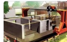
construção por impressora 3D
