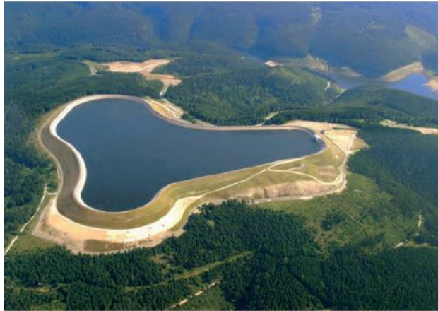
Figure 2-2 – Pumped Hydro Storage (Vattenfall, IEC MSB/EES Workshop, 2011)
